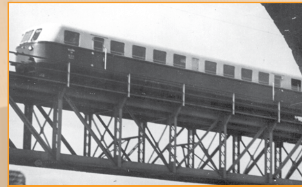
Sínautóbusz a biatorbágyi új viadukton, 1936
